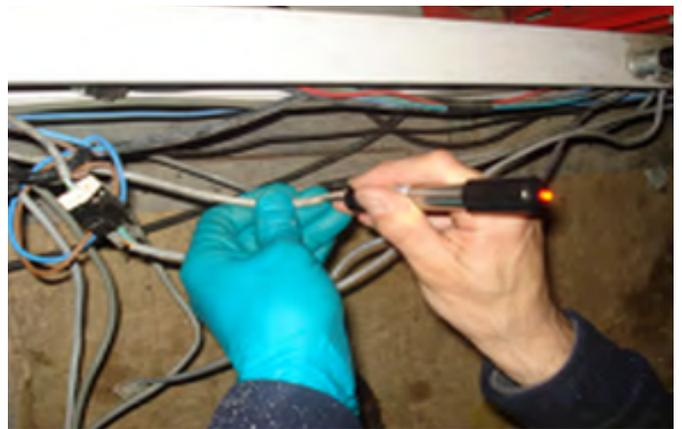
Sostenga el probador por el barril de metal y coloque la aguja o punta en el conector o cable (perfore el aislamiento si es necesario). El probador se encenderá y hará un zumbido cuando el voltaje positivo sea detectado.
